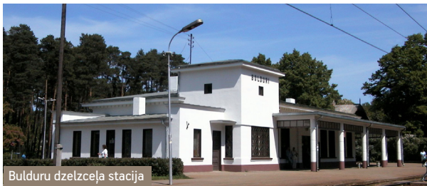
Bulduru dzelzceļa stacija
